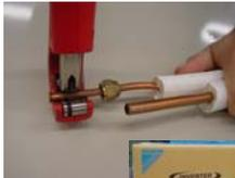
10. Eseguire l'installazione della nuova macchina ad R410A sulle tubazioni pulite
